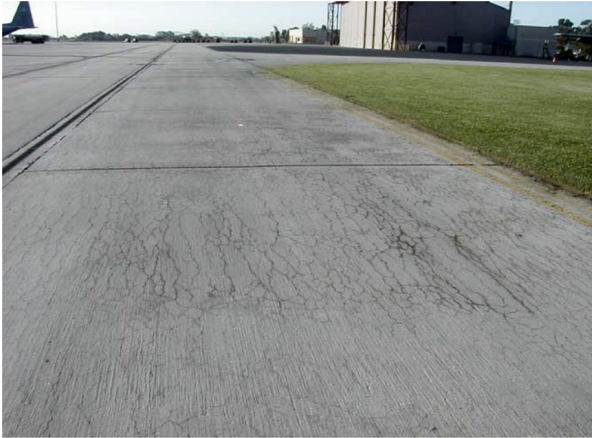
Bild 2.45: AKR-bedingte Netzrisssbildung auf dem Rollweg eines Flughafens [124]
