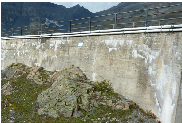
Bild 2.37: Netzrissbildung an einem AKR-geschädigten Staudamm, 64 Jahre alt (Schweiz, 2011)
